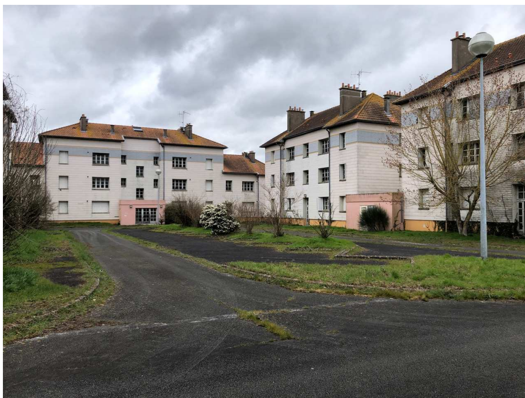
Photographie n°5 : vue sur l'ensemble de bâtiments Nord (février 2020)
