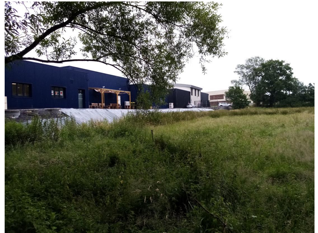
Photo n°5 : Vue sur les derrières des terrains n°1 et 2
