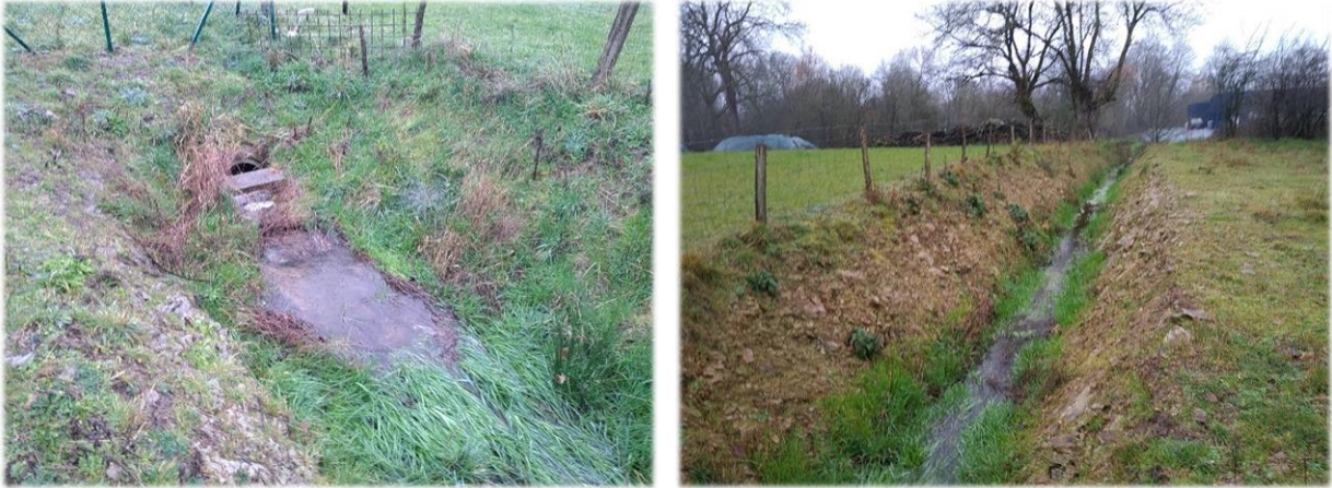
Figure 24 : Buse (à gauche) et fossé (à droite) (Source : NCA environnement)
