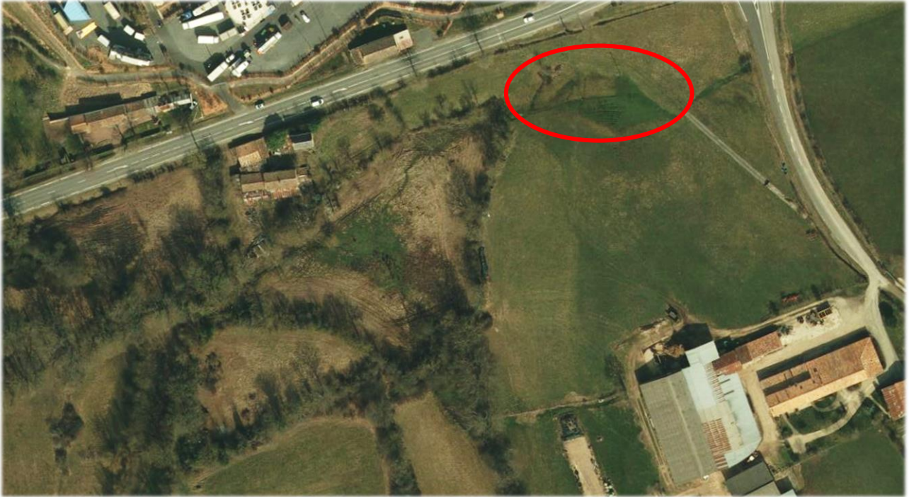
Figure 17 : Zoom sur la zone en 2010 avant tout travaux (Source : Géoportail)
