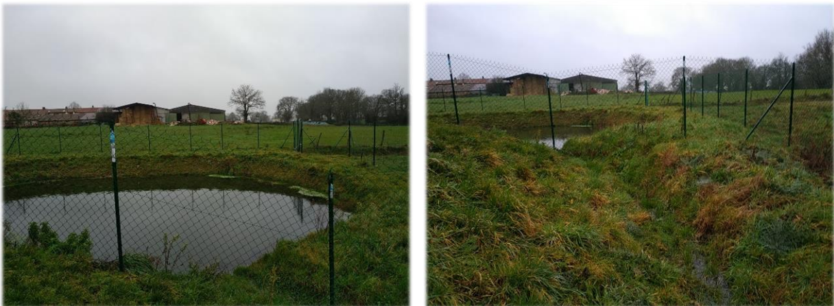
Figure 19 : Bassin tampon (gauche) et rigole allant jusqu'à la mare (droite) (Source : NCA environnement)
