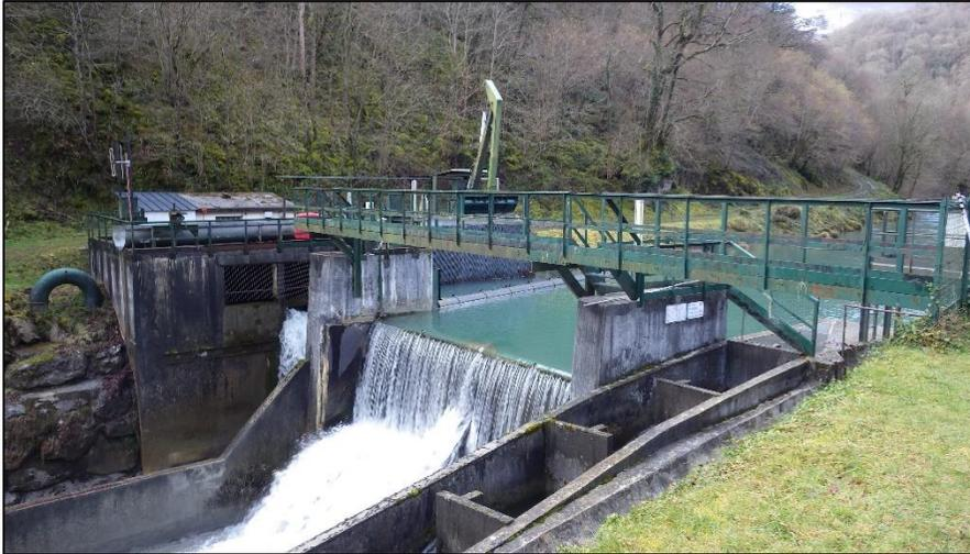
1/ Barrage, prise d'eau, clapet et passe à poissons actuelle (à modifier)
