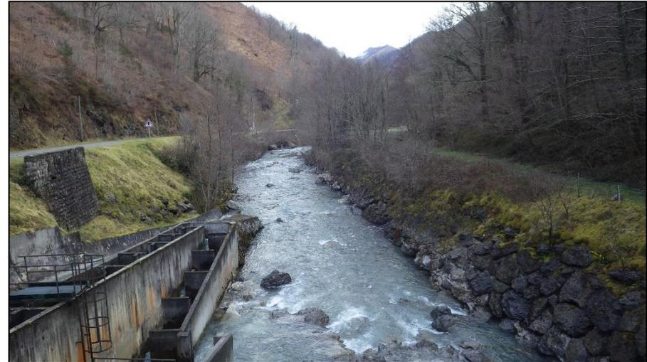
2/ Départ de la conduite forcée enterrée à droite et passe à poissons à gauche
