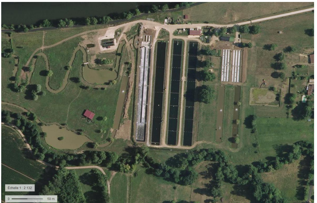
« Vue de dessus du terrain destiné au projet »
