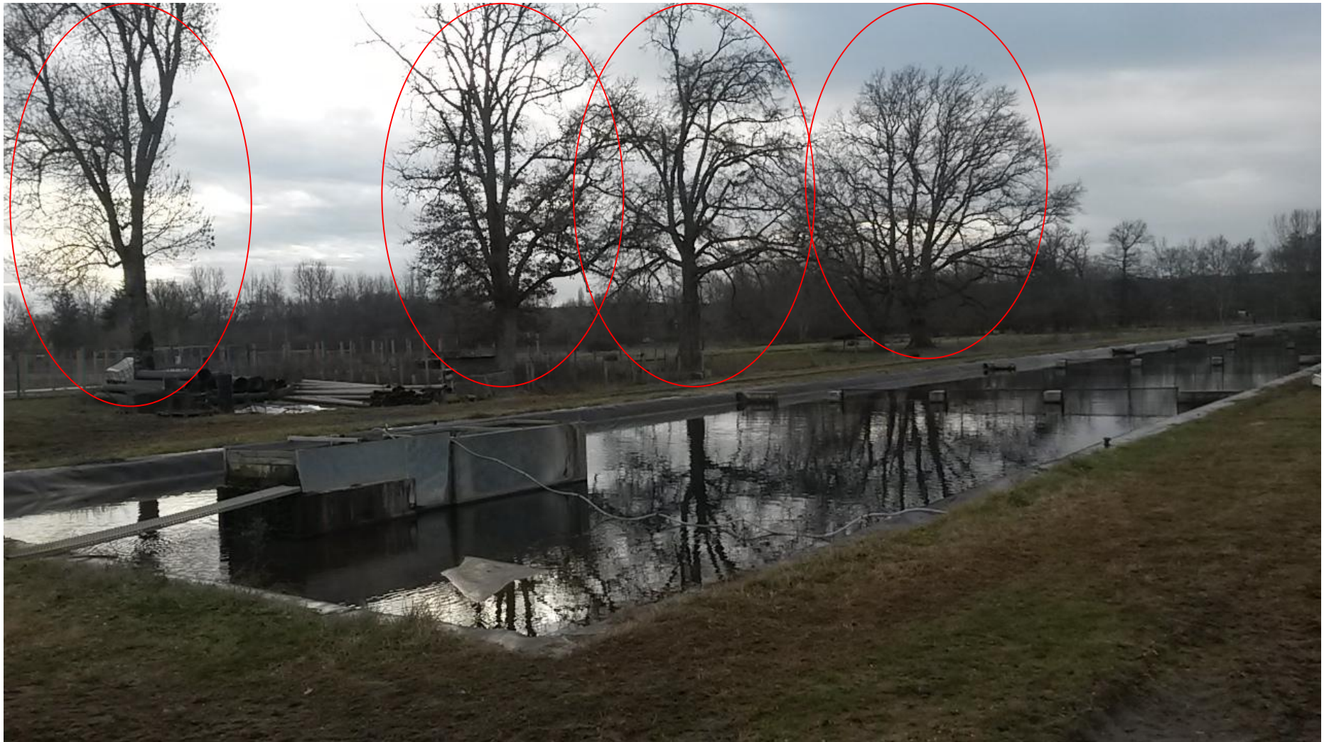
« Vue des arbres à élaguer pour supprimer l'ombrage sur les modules photovoltaïques »
