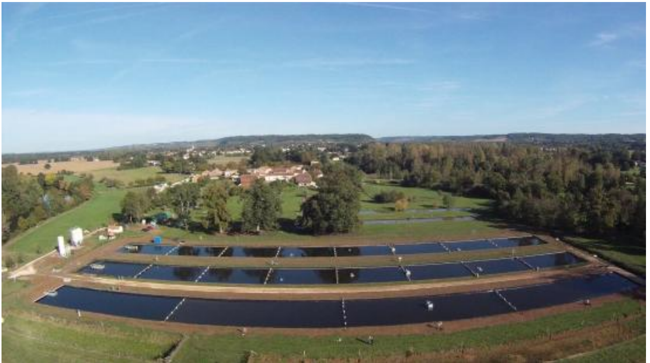
« Vue d'une partie des bassins existants à couvrir »
