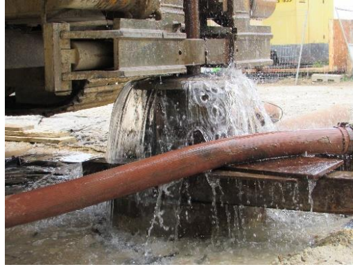
Cimentation sous pression : nettoyage du tubage API \varnothing 323 mm
