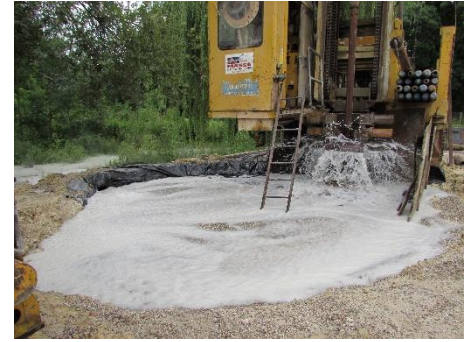
Reformation du sabot à bille et du réservoir du Cénomanién carbonaté
