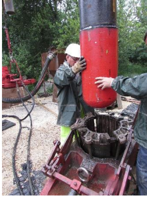
Pose du sabot à bille à la base du tubage API \varnothing 323 mm de 0 à -110 m
