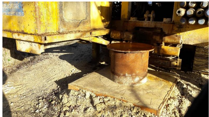
Tubages Acier télescopés Ø 800 mm et Ø 600 mm
