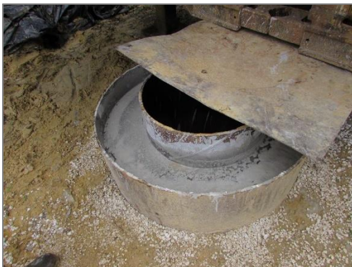
Tubages Acier télescopés Ø 800 mm et Ø 600 mm
