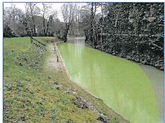
Quai en amont de l'écluse de Nazareth- Nérac
