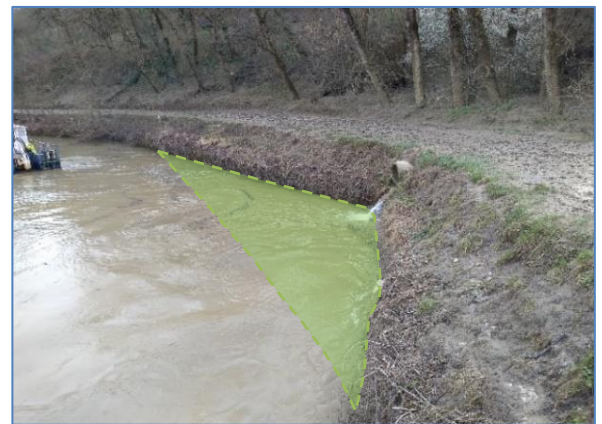
Curage en sortie de la buse
