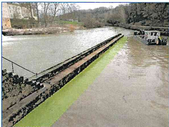
Guideau en aval de l'écluse
