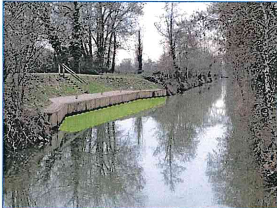
Quai en amont de l'écluse
