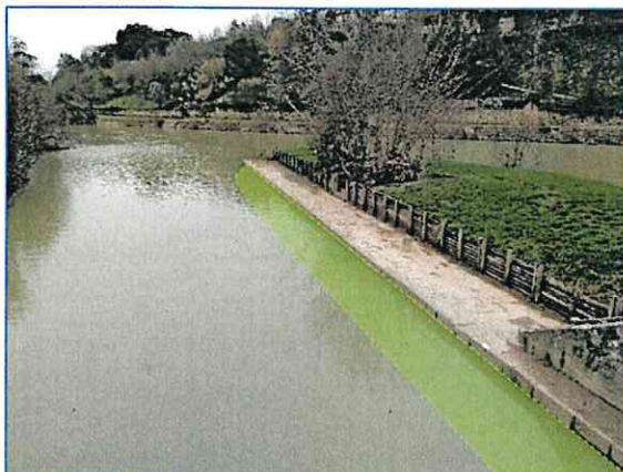
Guideau en aval de l'écluse de Nérac
