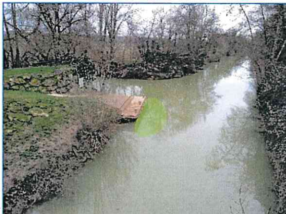
Ponton en aval de l'écluse de Moncrabeau
