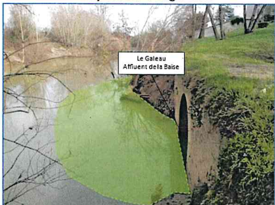
Point n°3 – Exutoire du ruisseau de Galeau à Trenqueléon - Feugarolles
