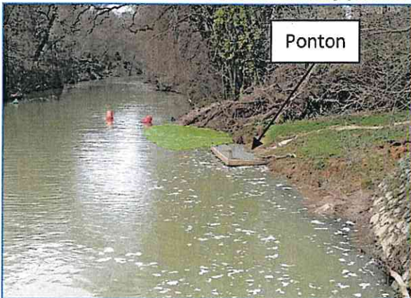
Ponton en aval de l'écluse de Saint-Crabary (Lavardac)
