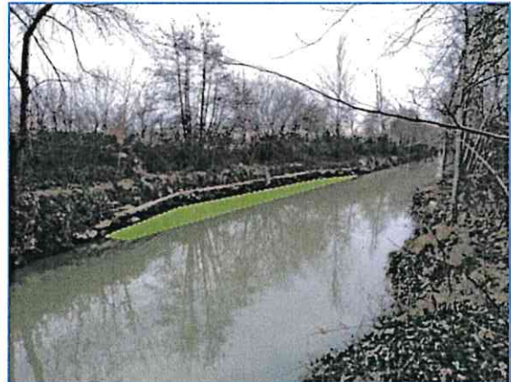
Aire de croisement des bateaux en amont de l'écluse
