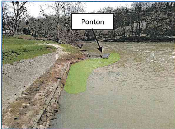
Ponton en aval de l'écluse
