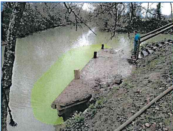
Ponton à l'aval de l'écluse de Lapierre - Moncrabeau
