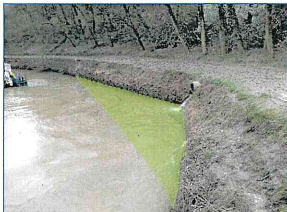
Sortie de buse en aval de l'écluse
