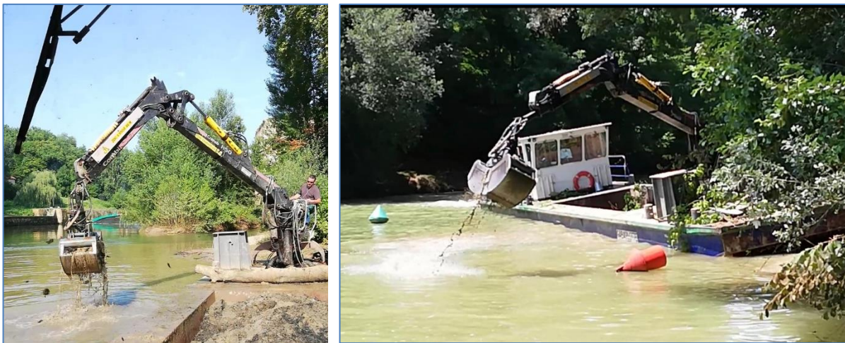
Figure 2 : Photo de la barge avec grue et benne preneuse (Source : CD47)
