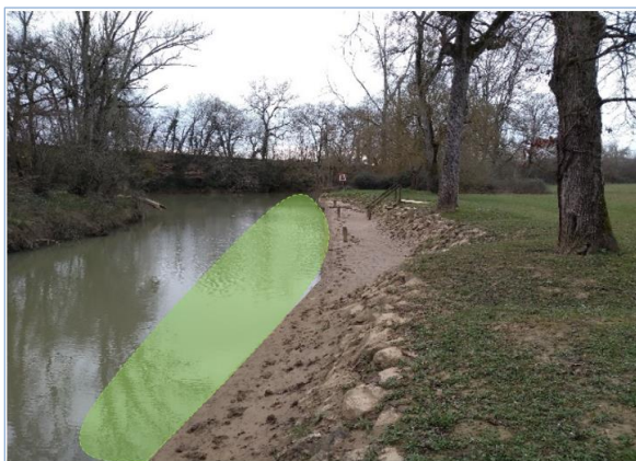
Quai en amont de l'écluse
