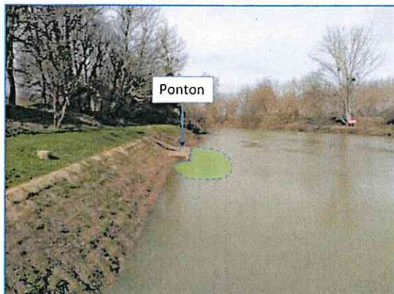
Point n°1 – Ponton en aval de l'écluse de descente de Buzet-sur-Baise
