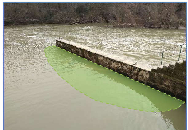
Curage au niveau du guideau aval
