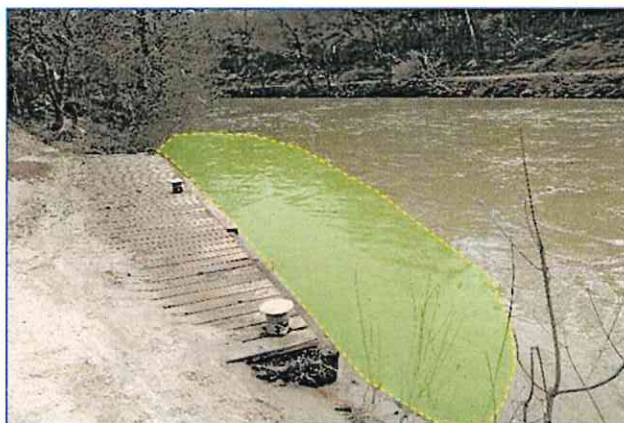
Point n°4 – Ponton en aval de l'écluse de Vianne
