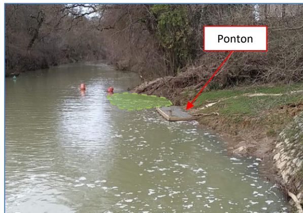
Curage en aval du ponton
