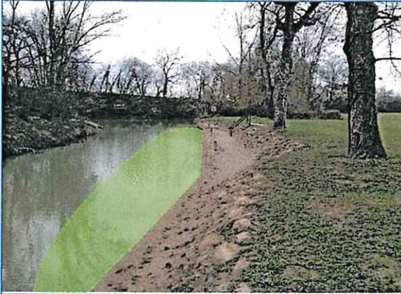
Quai en amont de l'écluse
