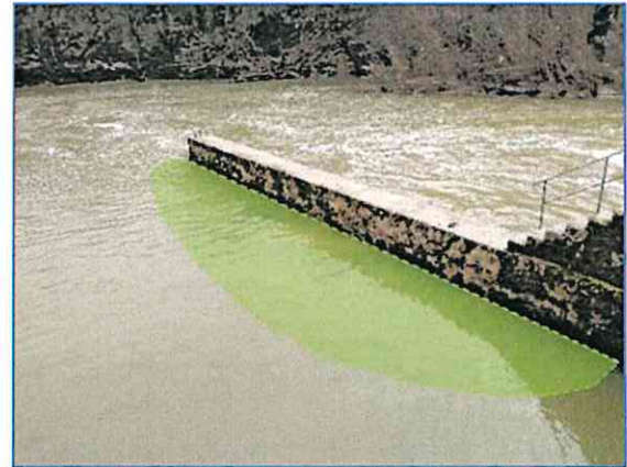
Guideau en aval de l'écluse
