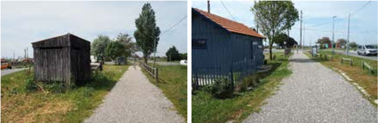
Figure 60 : Poste « le Griffault » (g), cabane ostréicole (d), mobiliers urbains et arbres en bordure de piste à l'extrémité Ouest du tronçon 1-1.
