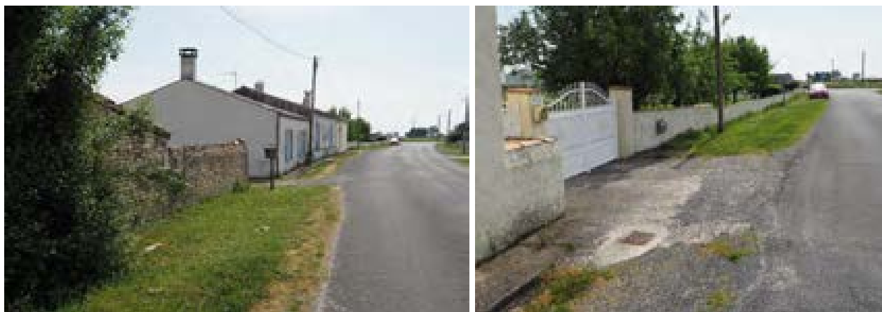
Figure 27 : Vue des sorties des deux habitations au nord de la rue du Viaduc, sur le tracé 3-1-Alt1.
