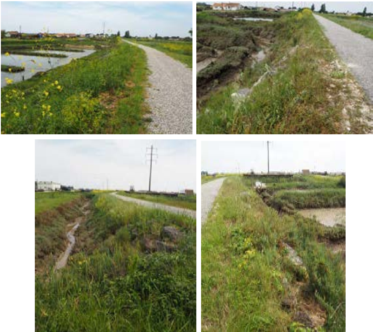
Figure 61 : Vues des chenaux d'alimentation parallèles à la levée et enrochements de soutènement des OH.
