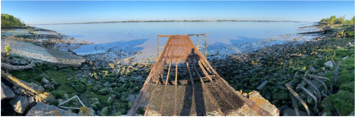
Photographie 1 du poste à péniche existant depuis l'est (accès terrestre à l'arrière)
