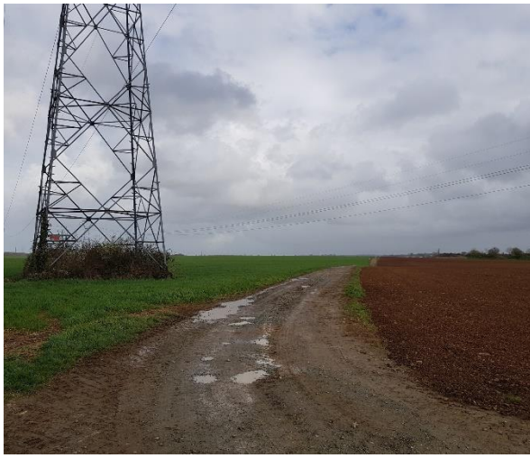
7 – Passage à proximité ligne RTE
