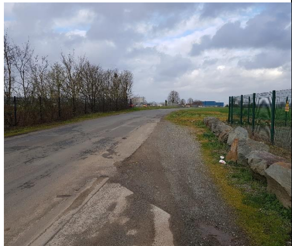
18 - Raccordement rue de la Génétéau
