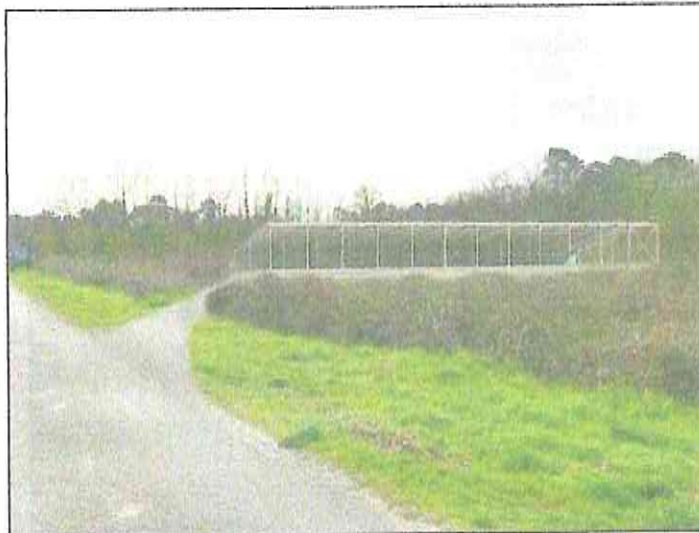
PC6 PHOTO 3 Après travaux Bâtiment Projet
