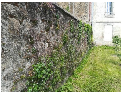
Figure 3 : Muret avec anfractuosités constituant un milieu rupicole de substitution (Source Artelia)
