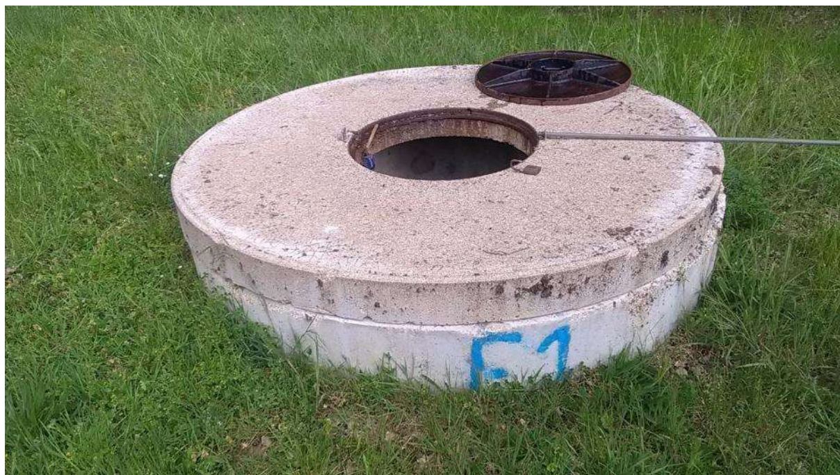
Vue de la tête du forage de « La Forêt » F1, le 29 avril 2021
