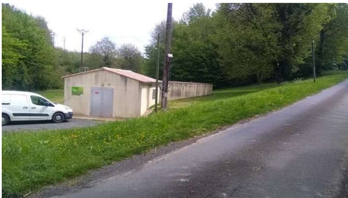
Chemin rural au premier plan, station de pompage et stockage de 500 m 3 au second plan, le 29 avril 2021
