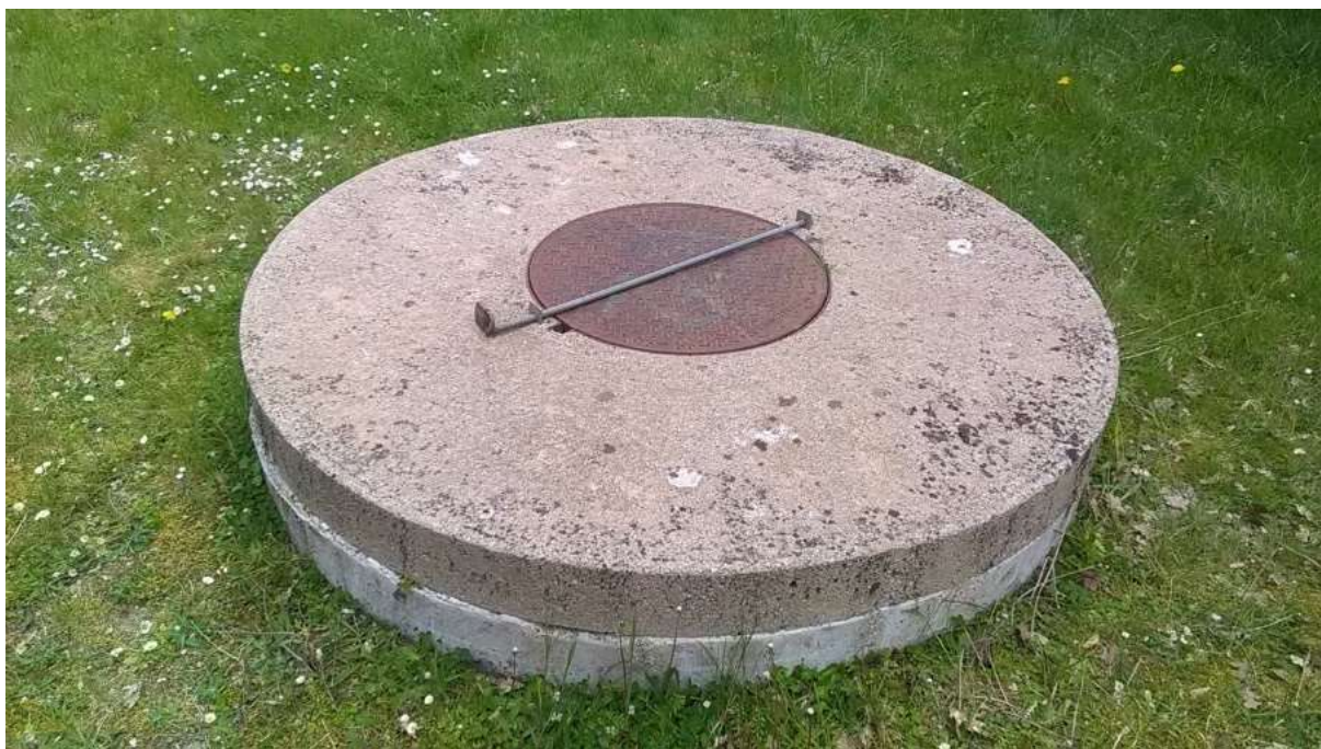
Vue de la tête du forage de « La Forêt » F2, le 29 avril 2021
