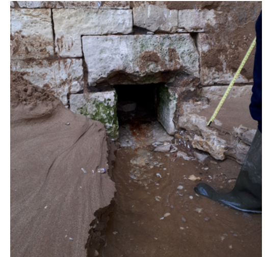
L'ouvrage existant subissant un ensablement régulier
