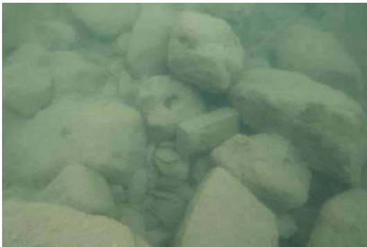
Enrochements à l'aval du seuil
