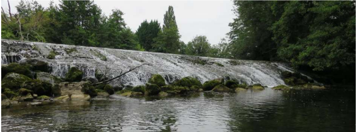
Figure 3 : Haut : vue aval de la centrale hydroélectrique ; milieu : seuil en rive droite ; bas : seuil en rive gauche.
