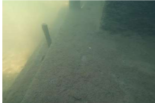
Seuil du pont d'accès au moulin
