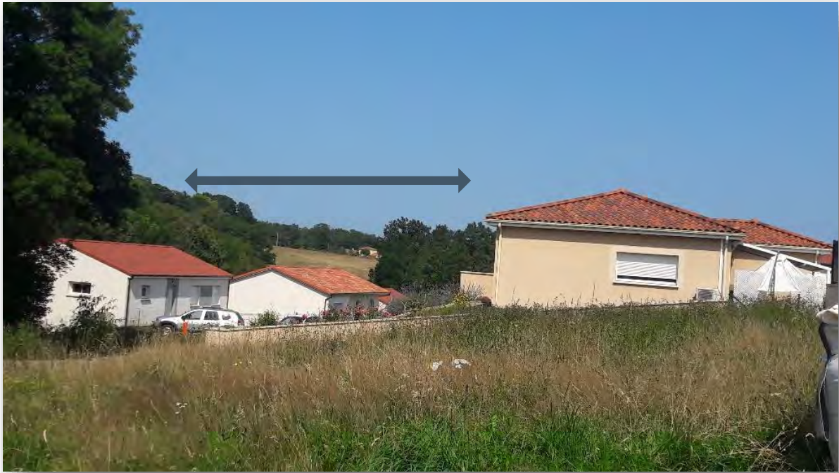
Photo 10 : Vue lointaine vers le site du projet (date de la prise de vue : 22 juillet 2021)
