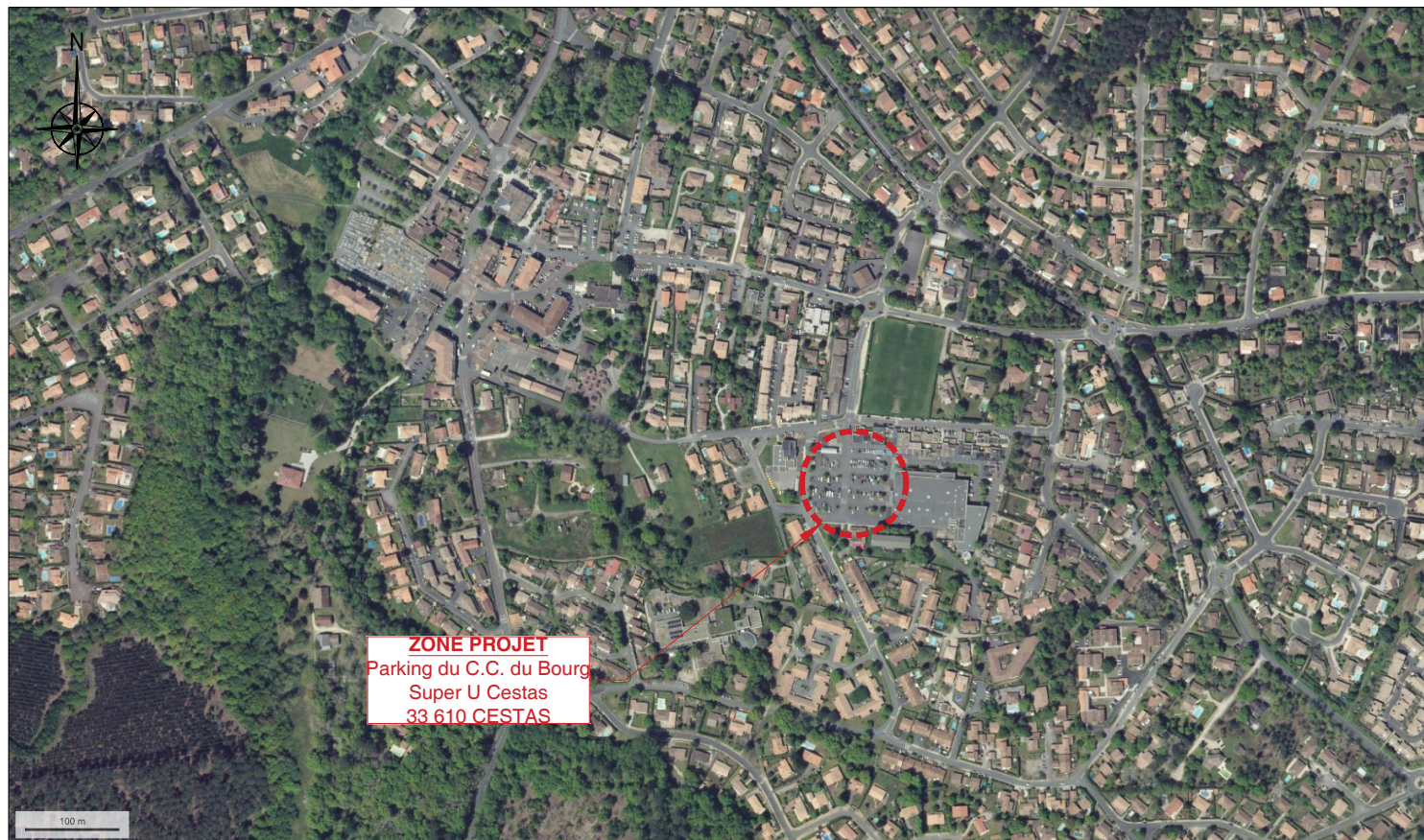
Vue aérienne lointaine - Echelle graphique
