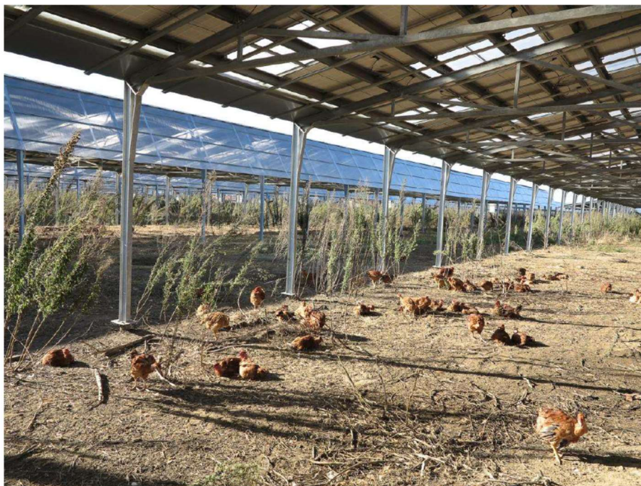
Figure 11 : Exemple d'Abri à volaille photovoltaïque implanté dans un parcours extérieur d'un élevage de volailles
