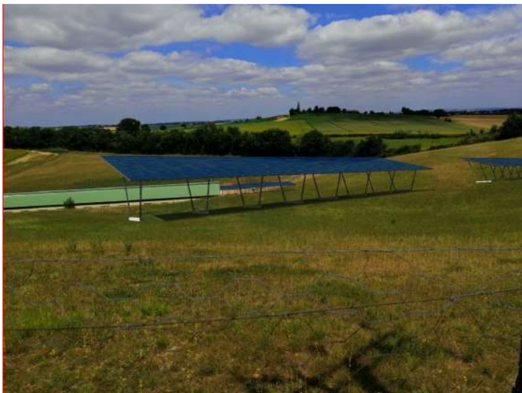
Figure 10 : Abri à volaille photovoltaïque pour parcours de volailles plein air (doc Novafrance Energy)
