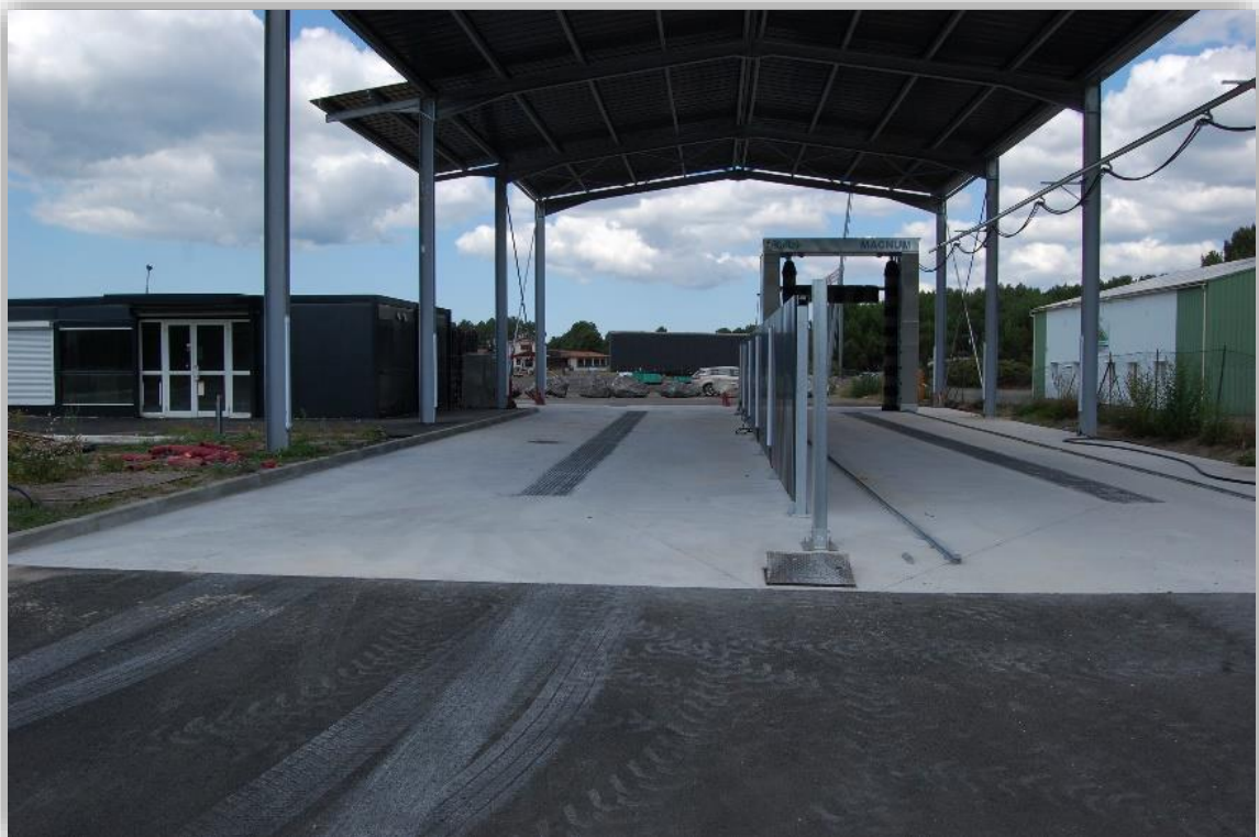
⑩ La nouvelle aire de lavage en cours de construction en août 2021
