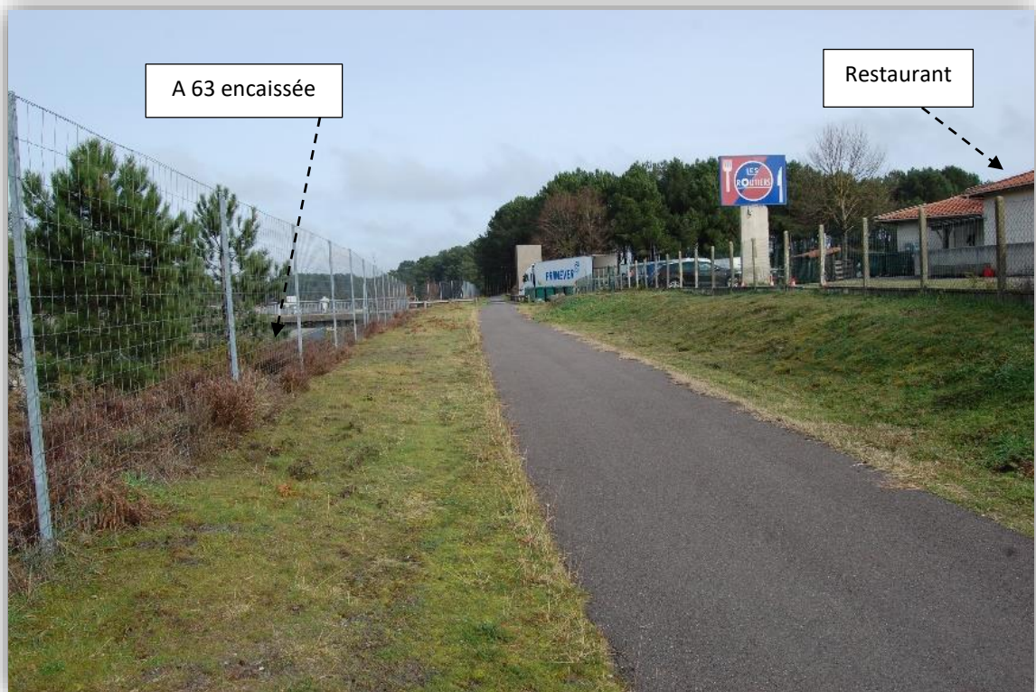
❶ Piste cyclable au Nord entre le restaurant et l'A63 en contrebas
