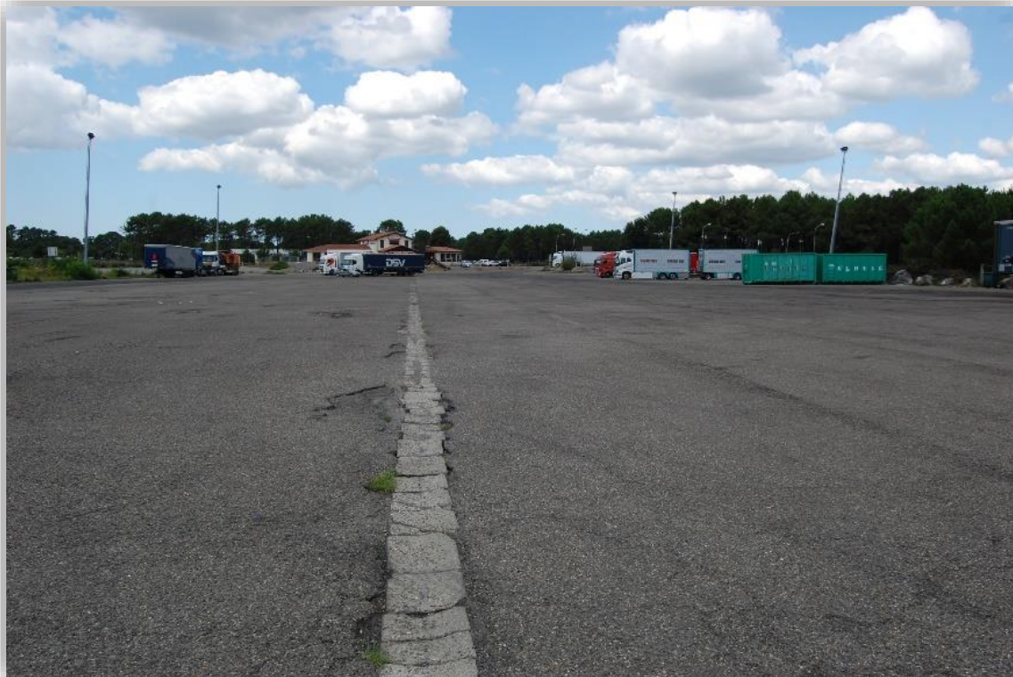
11 Vue d'ensemble du parking central
