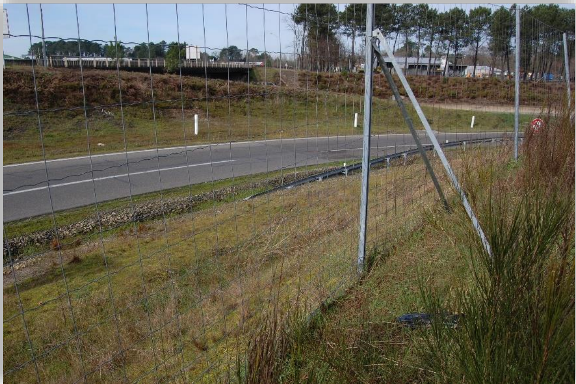
③ Bretelle d'accès à l'A63 en limite Ouest
