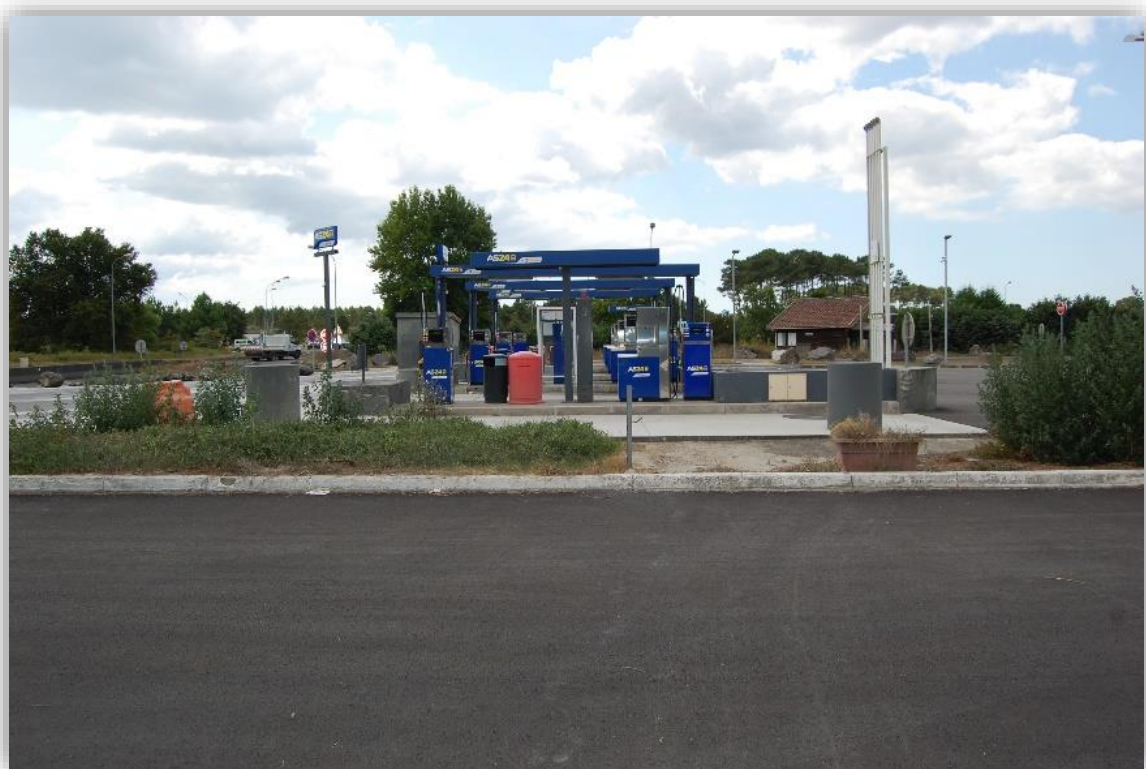
8 La station-service vue depuis l'aire de lavage
