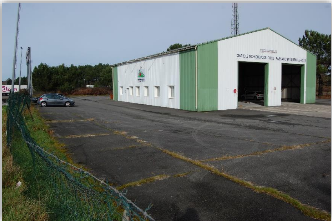
⑨ La centre de contrôle technique en léger contrebas du site
