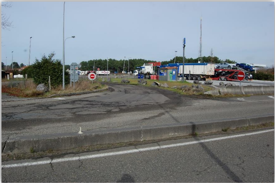
7 La station-service vue depuis le Sud au niveau de la route du centre routier
