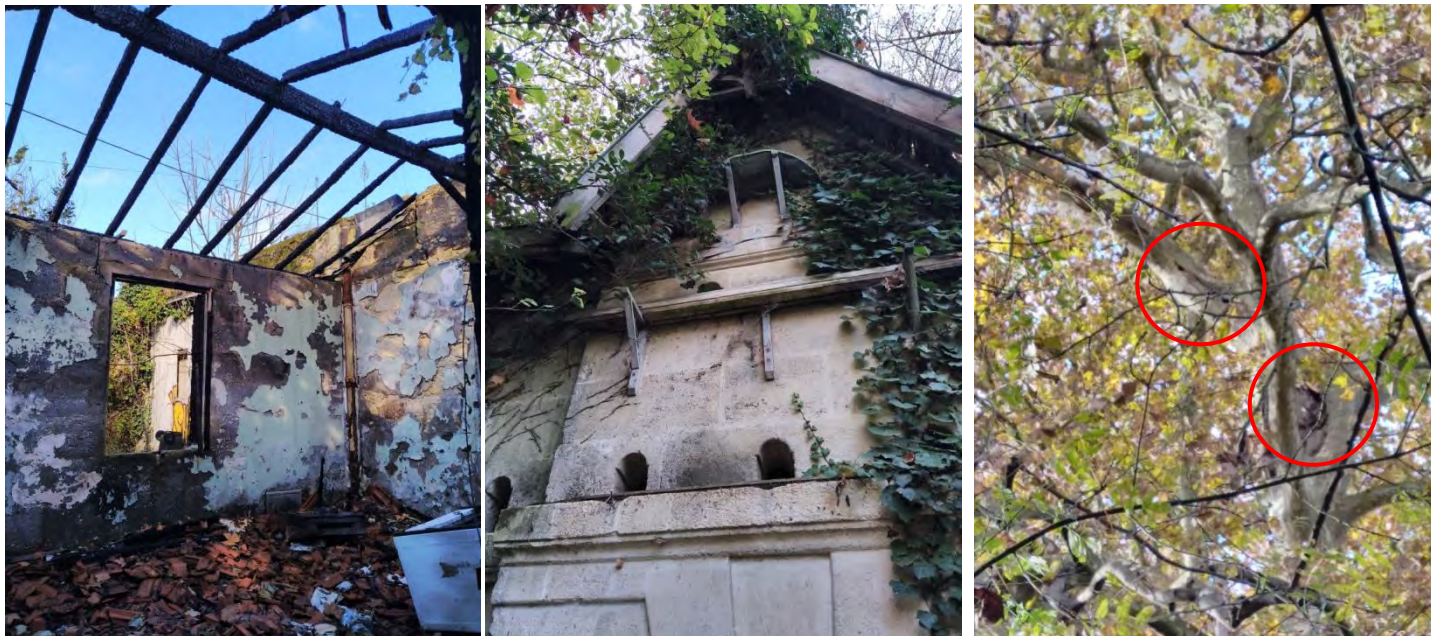
Photo 4 : Bâtiment en ruine (gauche), pigeonnier (centre), platane avec cavité (droite)
