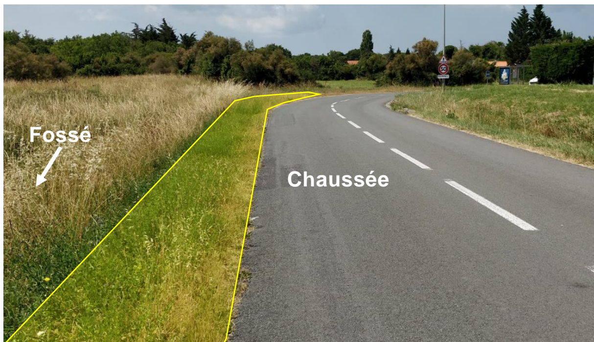
Figure 47 : Photographie de la chaussée - Route des Huîtres
