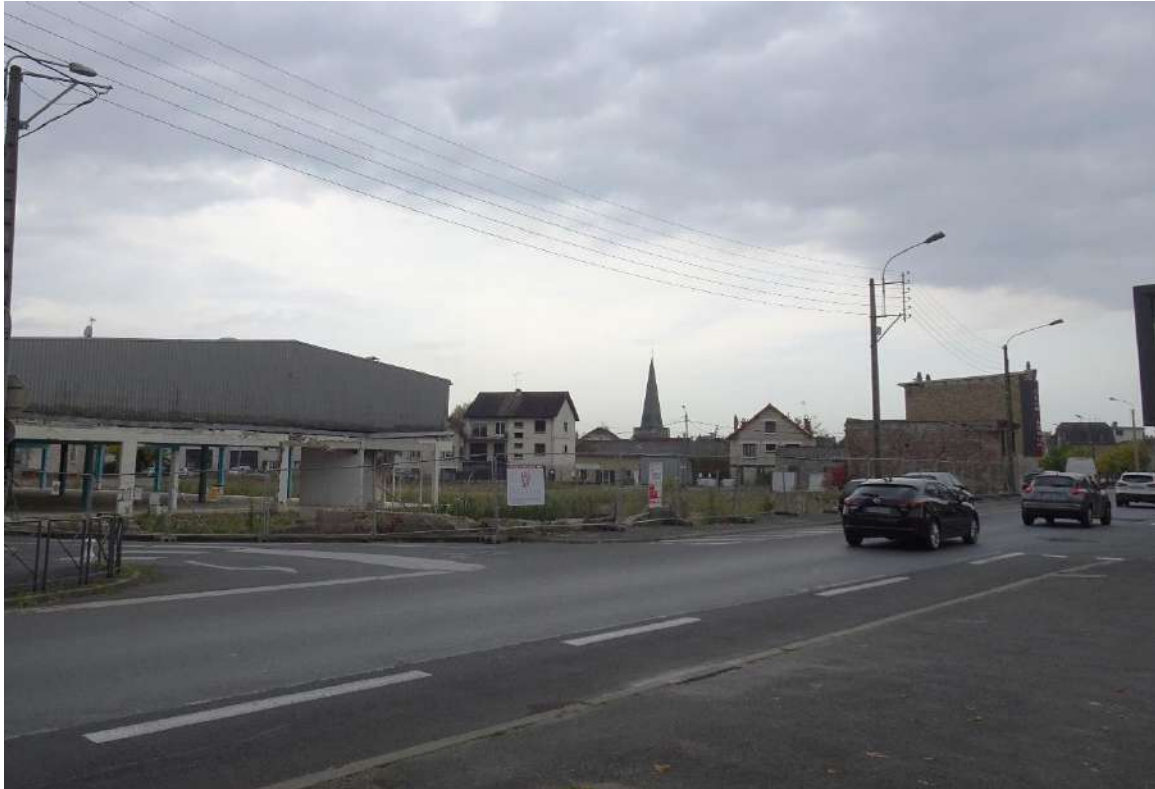
Photographie 1 : Vue lointaine du site d'étude (Source : ENCIS Environnement)
