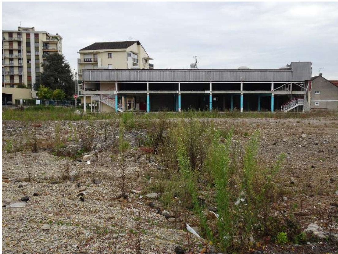
Photographie 4 : 1 er bâtiment à démolir vue de face (Source : ENCIS Environnement)
