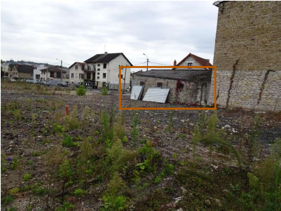
Photographie 5 : 2 ème bâtiment à démolir (Source : ENCIS Environnement)
