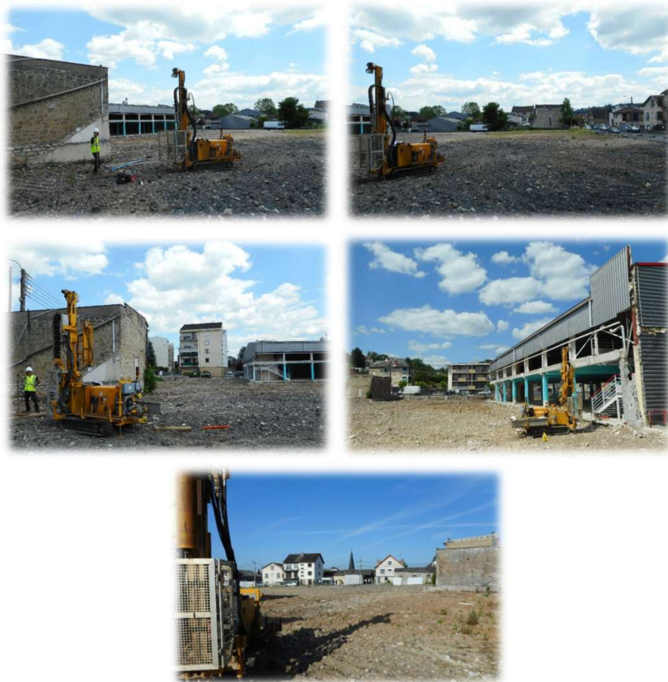
Etat actuel du terrain lors de notre intervention [ECR Environnement – 09/06/2021]
