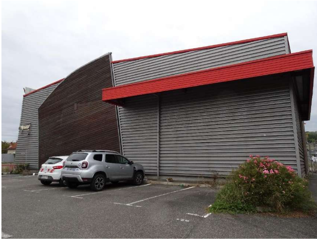
Photographie 3 : 1 er bâtiment à démolir (Source : ENCIS Environnement)
