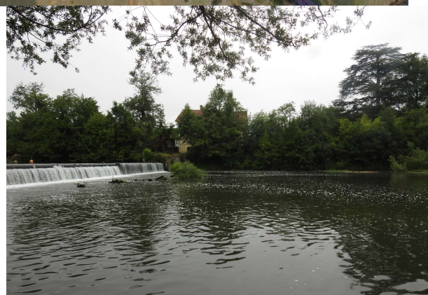
Vue depuis la rive droite, en aval du futur emplacement de la centrale
