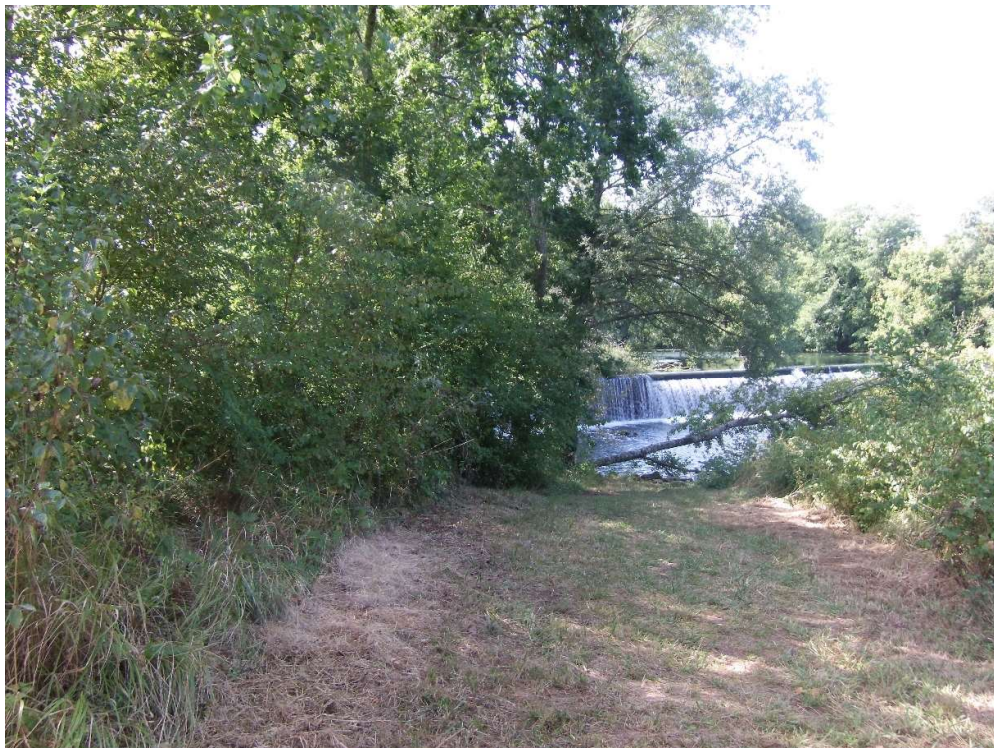
Photographie 3 -- Zone implantation de la centrale vue depuis l'aval (Sept 2019)
