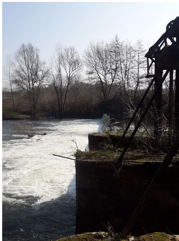
Photographie 1 – Seuil vu depuis le bajoyer rive gauche (Janv 2019)
