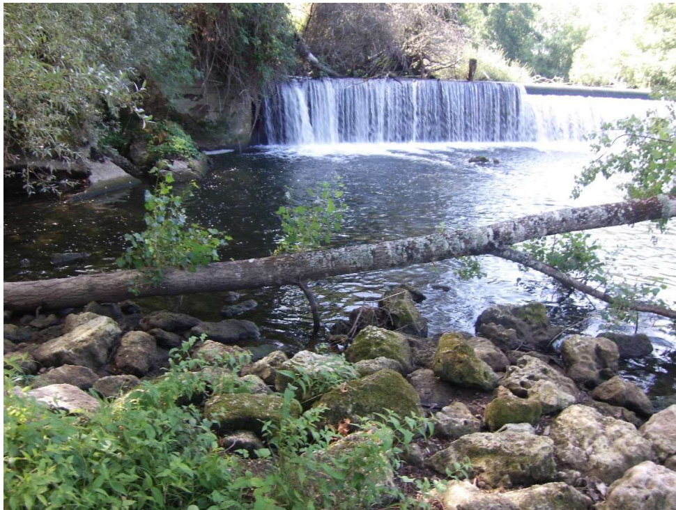
Photographie 4 – Zone implantation de la centrale vue depuis l’aval (Sept 2019)
