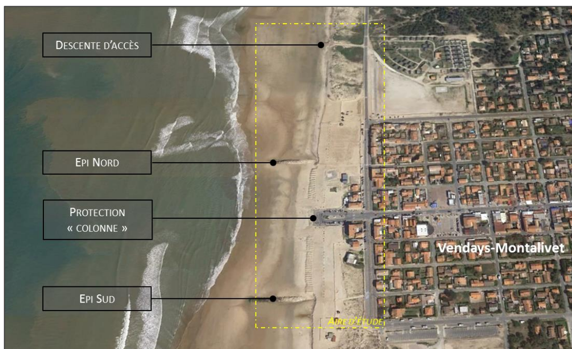
Figure 2 : Localisation des ouvrages rencontrés sur le littoral de Montalivet
