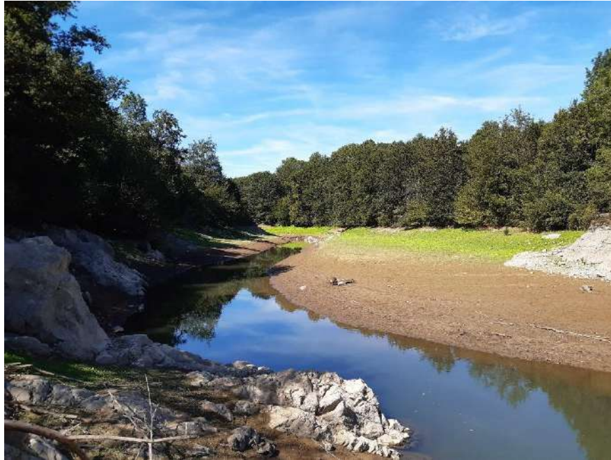
Photo 12 : Zone d'implantation de la digue au niveau du CHAMBON
