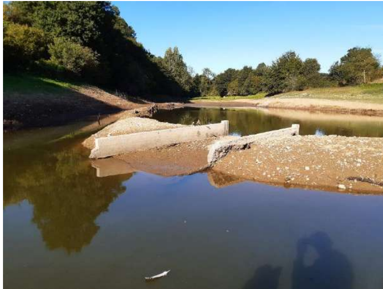
Photo 11 : Digue + seuil présent sur la zone de l'étang
