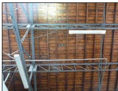
Vue sur le plafond en planches de bois du bâtiment n° 6 (source : Écosphère)
