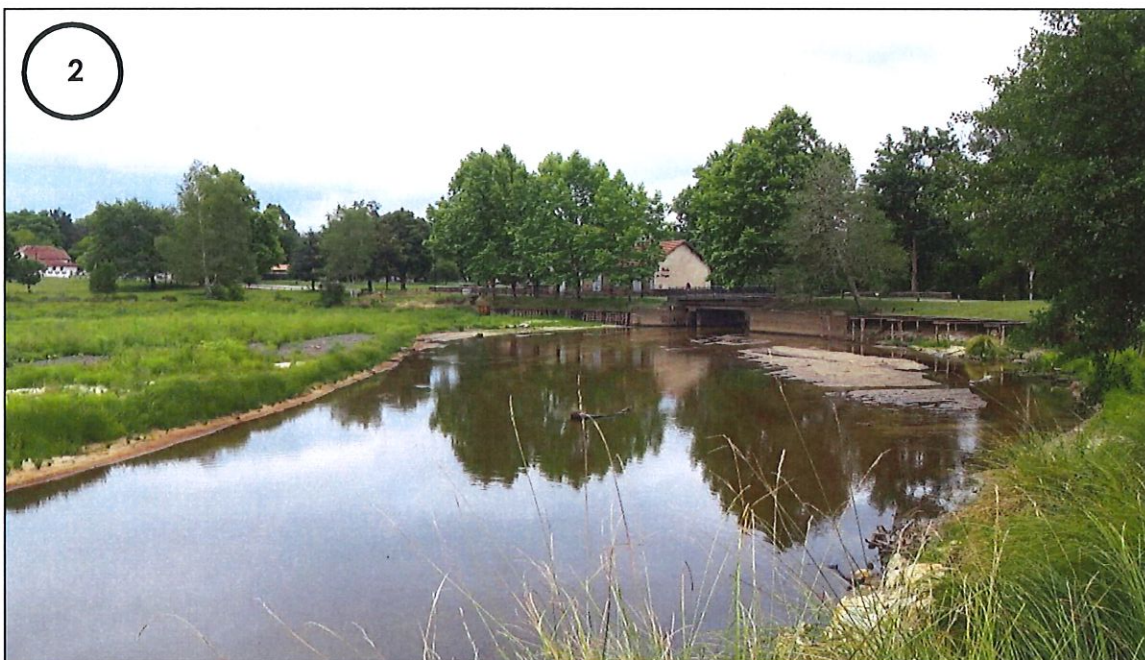
Prise de vue vers le Sud-Est depuis la berge Sud de l'Étang des Forges (IDRA, 27-07-2021)
