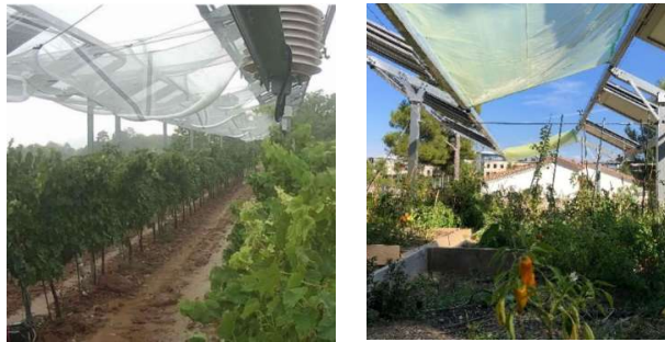
Figure 6 - Démonstrateurs de filets anti-grêle et bâches anti-pluie installés sur l'ombrière
