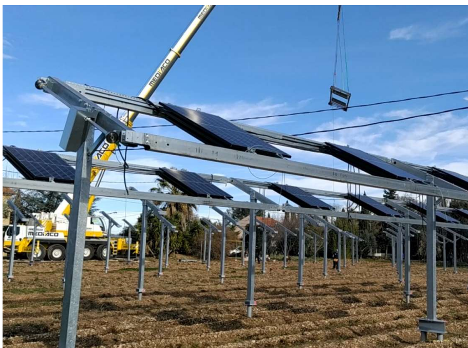
Figure 10 : Montage des tables par grue sur une culture de pivoine dans le Var en février 2021.
