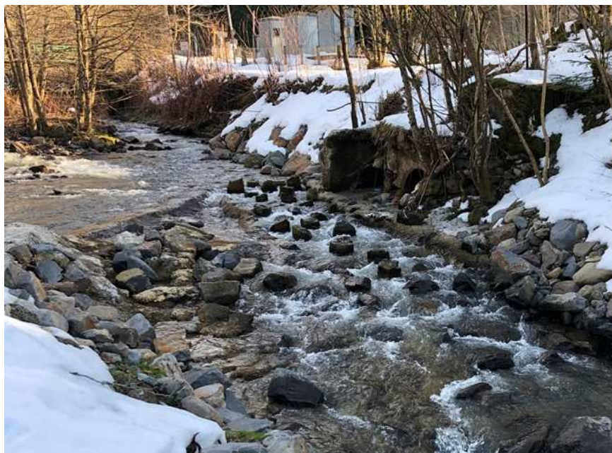
Photo 2 : Exemple de coursier à macrorugosités (Moulin de la Compiassade (63) – AJI 2018)
