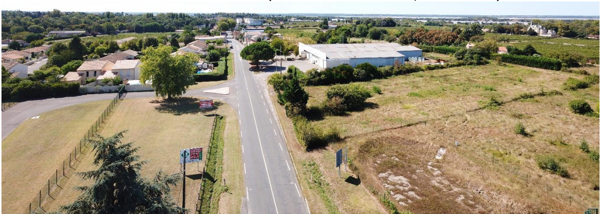
Vue aérienne de la RD937 en direction de Blaye (source : Permis de construire, décembre 2021)
