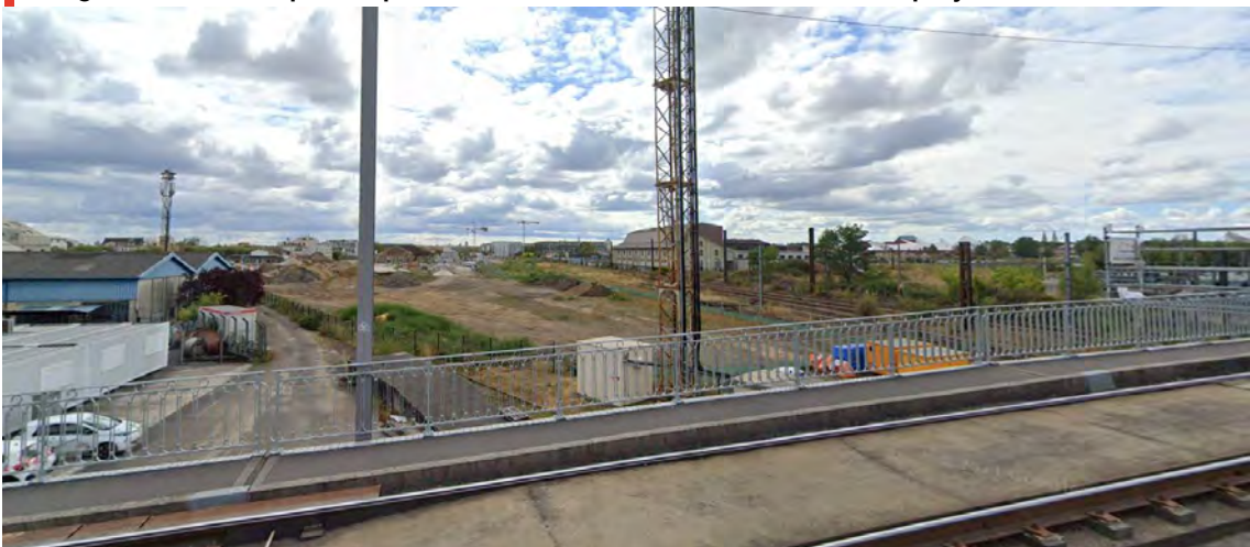
Figure 35 : Vue depuis le pont Bouthier à Bordeaux vers le site de projet
