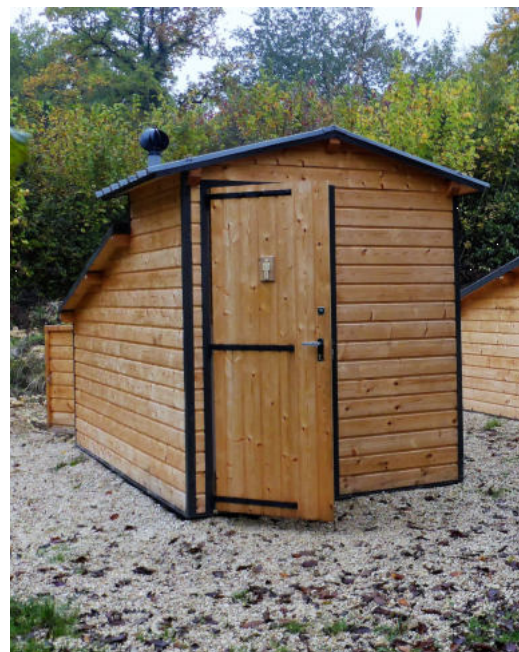
Toilettes sèches avec lombricompostage.
