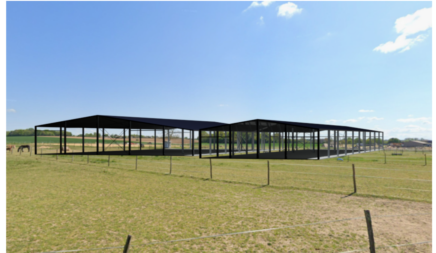
Après projet : vue 1 Depuis le chemin d'accès vers le hangar
