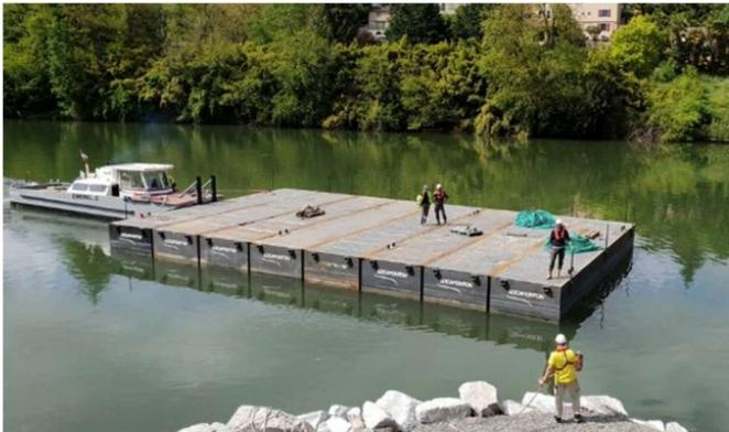
*Figure 3 Assemblage et positionnement d'une barge de levage de levage sur rivière (source : [www.locaponton.com](http://www.locaponton.com))*
