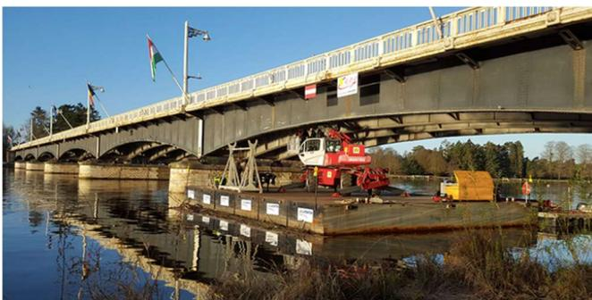
*Figure 4 Travaux aériens sous un pont routier réalisé par un engin de levage sur une barge fluviale dimensionnée et stabilisée depuis la berge et les bords (source : [www.locaponton.com](http://www.locaponton.com))*
