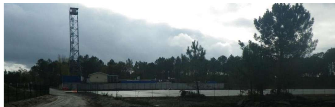
Figure 18 : Centre de transfert de Mios pour la gestion des déchets.
