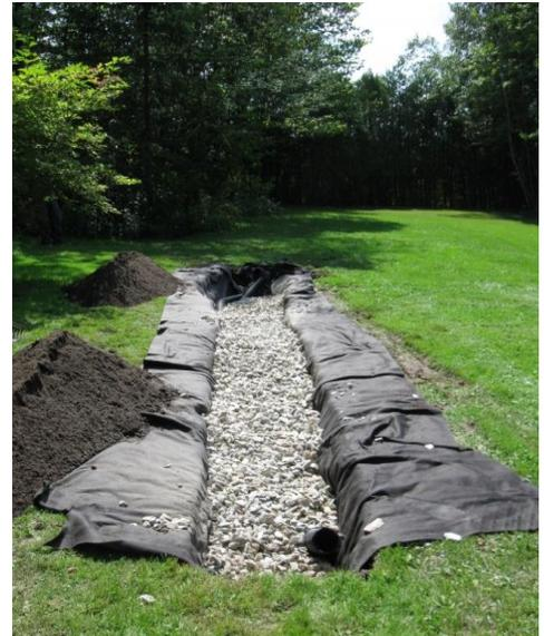
Figure 1 : Exemple de tranchée d'infiltration
