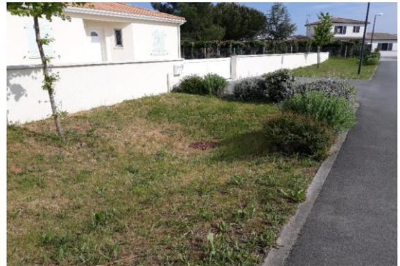
Figure 1 : Exemple de noue d'infiltration n°1
