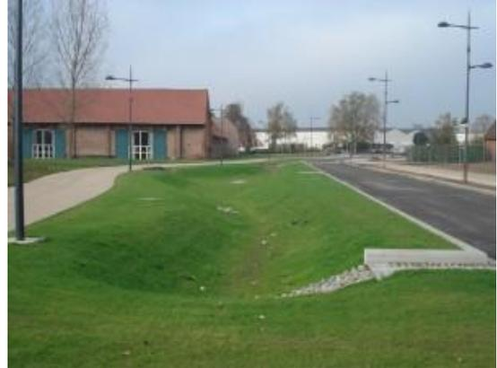
Figure 1 : Exemple de noue d'infiltration n°1
