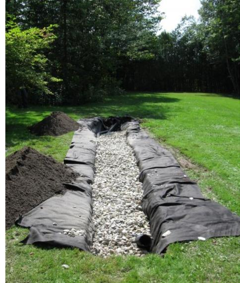
Figure 1 : Exemple de tranchée d'infiltration
