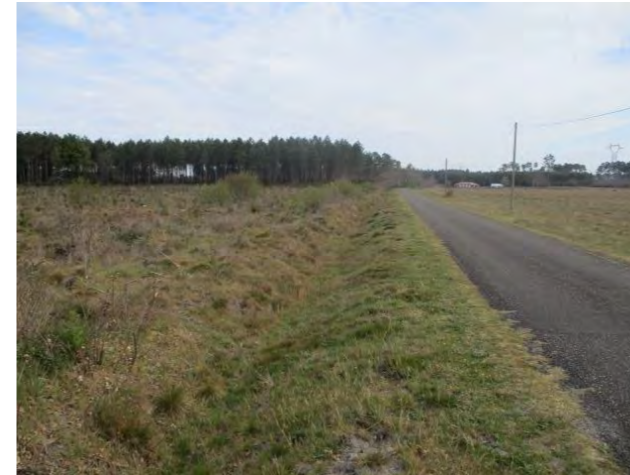
Figure 15 : Photographie du fossé longeant la partie ouest de la route de Bas
