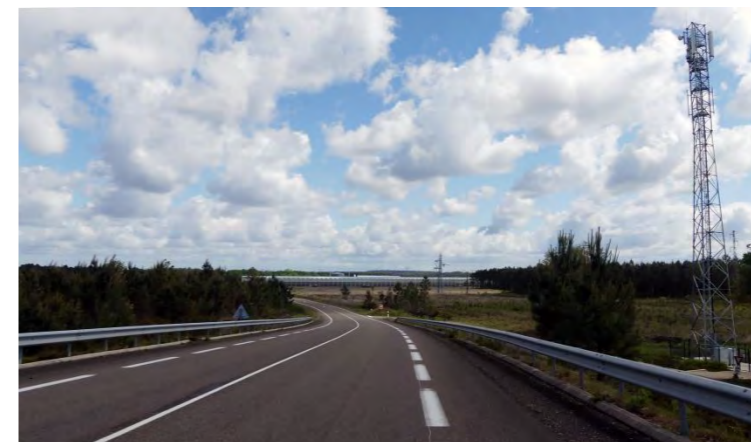
Vue 14 sur la route RD27 dans le secteur de l'airial du Moutéou
