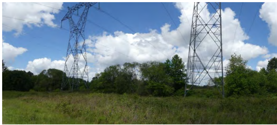
Vue 17 sur l'extrémité Sud de la ZIP au passage de la ligne électrique triple
