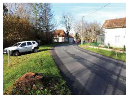
Traversée de la RD 75 à Javerlhac
