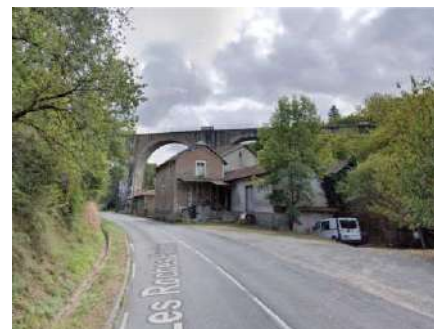
Viaduc du Refuge sur la RD 75
