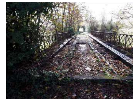
Pont de la voie ferrée sur le Bandiat
