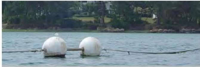
Figure 63. Photo d'un mouillage à embossage avec haltères
