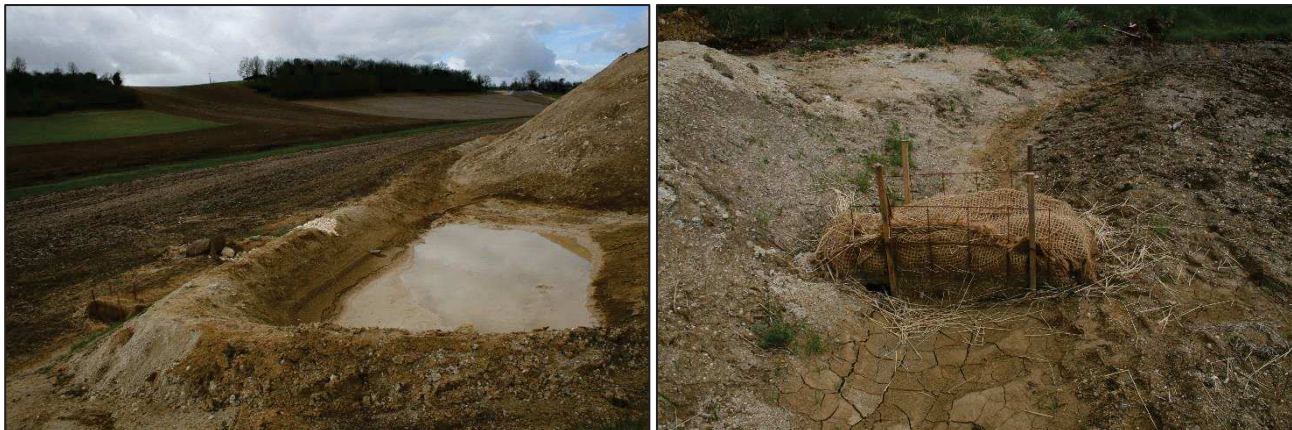
Figure 20 : Bassin de décantation temporaire des eaux de ruissellement en phase de chantier avec filtre à paille en sortie
