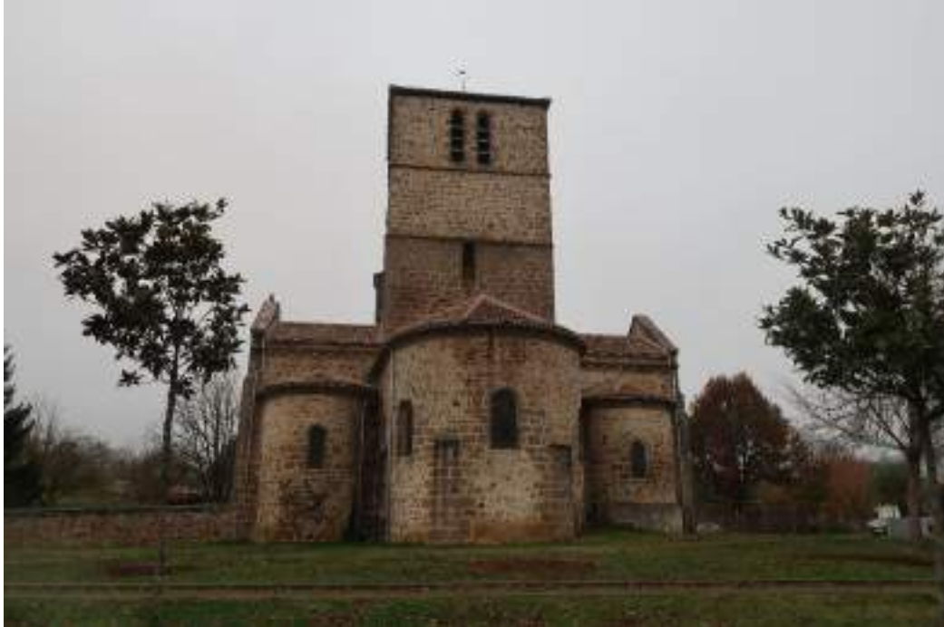
Photographie 14 : Vue de l'église Saint-Barthélemy (Source : ENCIS Environnement)
