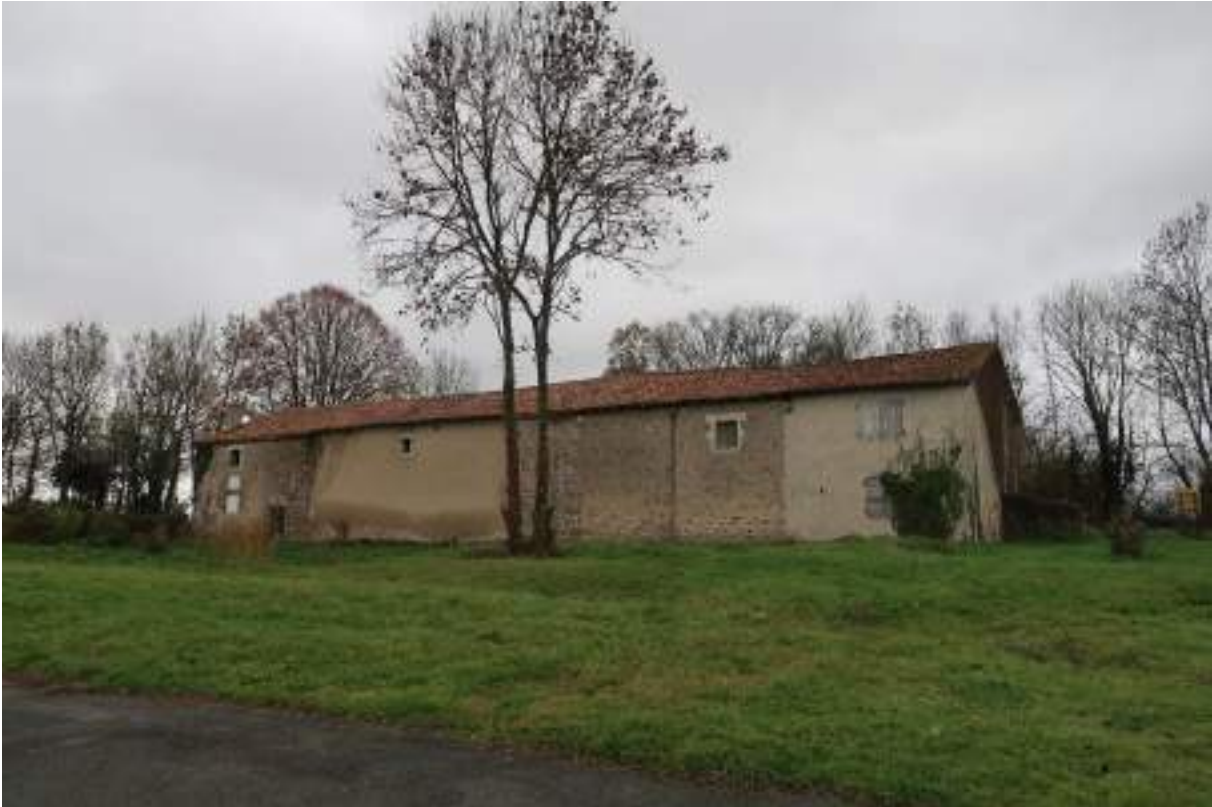
Photographie 5 : Bâtiment agricole sur la parcelle cadastrale 946 (Source : ENCIS Environnement)
