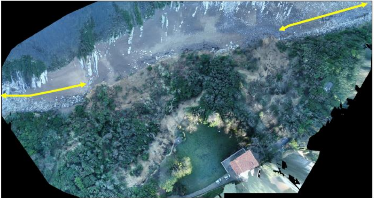
Figure 16 : Linéaires de falaise protégés par des enrochements de pied (en jaune) (Source : ANTEA GROUP)
