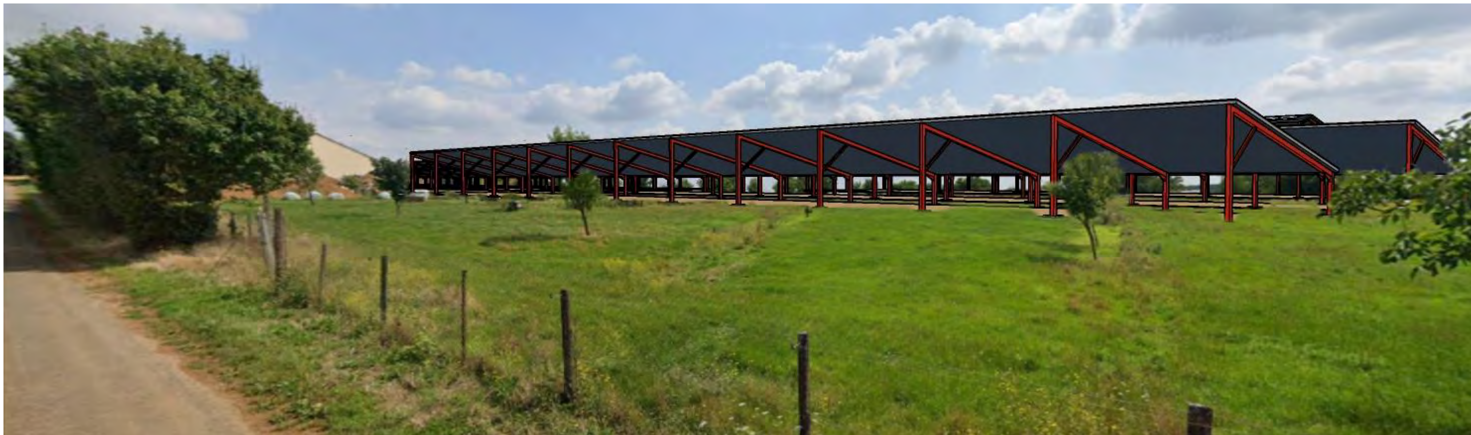
Entrée ouest du site
