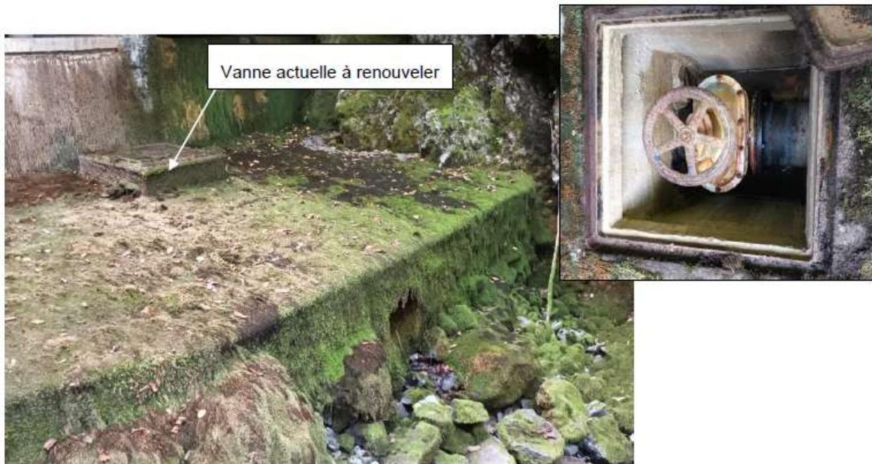
Figure 7 : vue de la vanne de vidange à remplacer (source : HEA)
