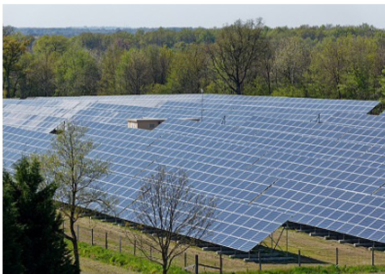
Centrale solaire réalisée sur des anciennes surfaces de stockage de déchets Le Vigeant (86)
