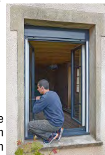
Pose d'une fenêtre double vitrage en rénovation
