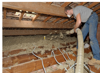
Isolation des combles par soufflage de laine minérale
